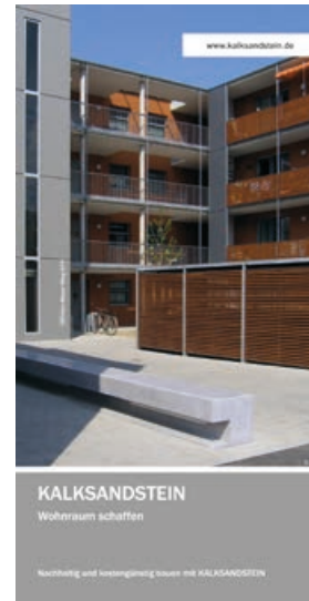
Bild 10 Aktuell wird in vielen Kommunen und Gemeinden aufgrund der Flüchtlingssituation schnell kostengünstiger Wohnraum benötigt.
