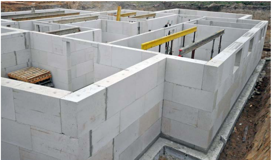
Bild 5 Keller, aus KS XL-Elementen erstellt
