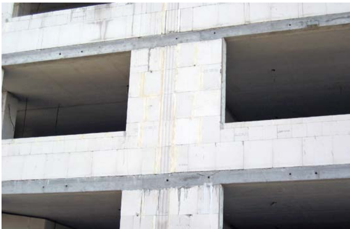
Bild 42 Durch die Außenwand durchgeführte Wohnungstrennwand
