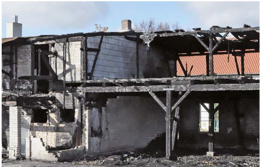
**Bild 11** Durch einen Brand verkohlte Holzkonstruktion vor einer unversehrten Kalksandsteinwand; wegen ungetrennten Dachanschlüssen wurde das Feuer weitergeleitet.
