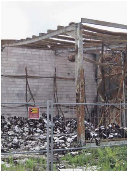
**Bild 10** Durch Brand verformte Stahlkonstruktion vor unversehrter Kalksandsteinwand
